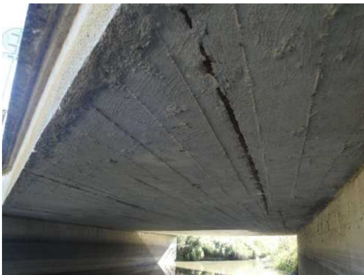
Podhled nosné konstrukce, vyhrězlý prut rozdělovací výztuže
