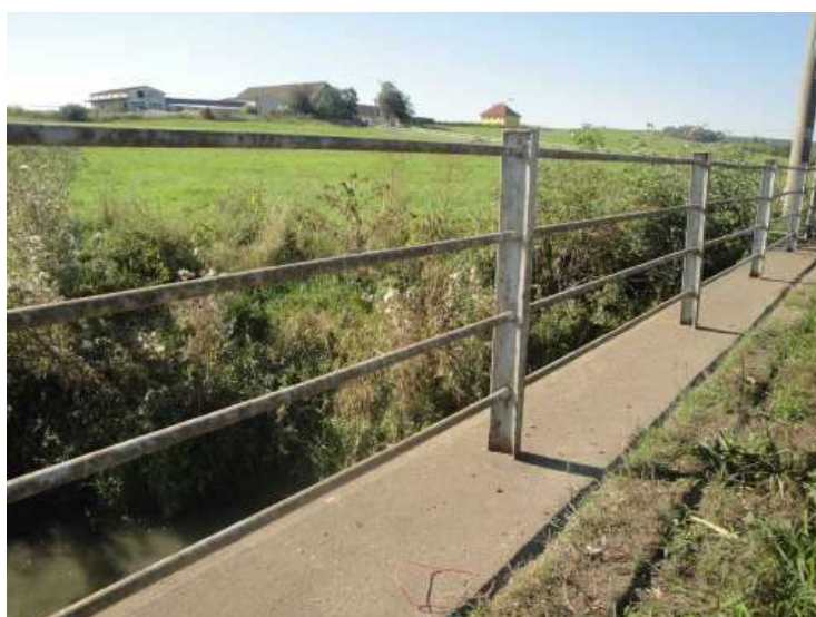
Zábradlí vlevo, odprýskující PKO, povrchová koruze
