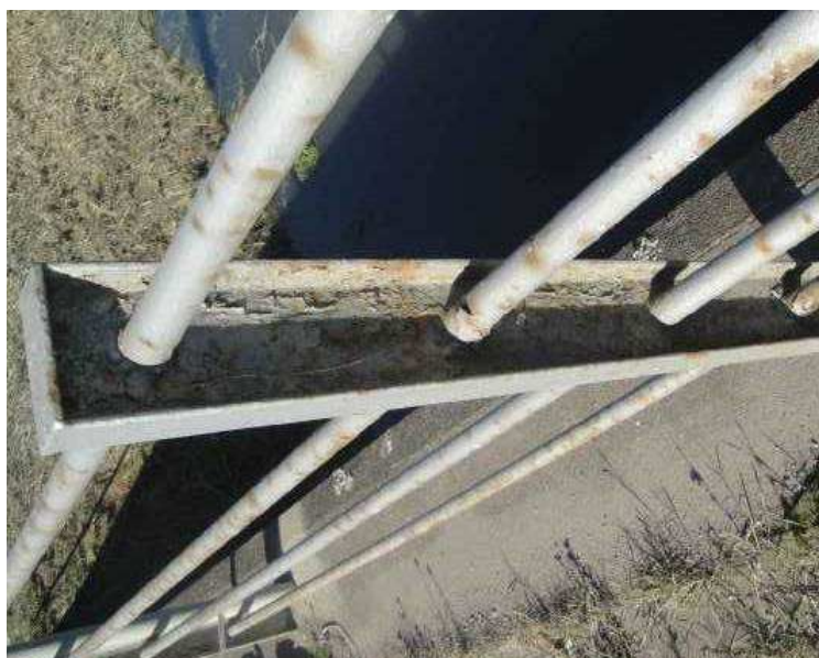
Zábradlí mostu vpravo, odprýskující PKO, korozní výkvěty
