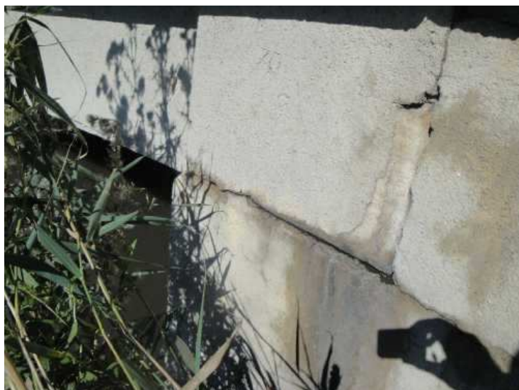
Uložení žb desky vlevo u opěry 1, průsaky dilatační spárkou, potečení dřívku opěry se zabarvením po průsacích
