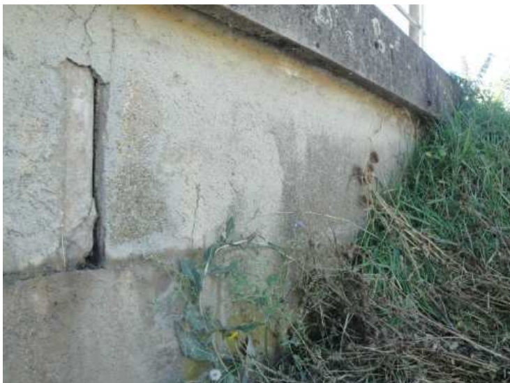
Pravé křídlo opěry 2, zvlhlý povrch v úrovni úložného prahu, průsaky z dilatační spáry
