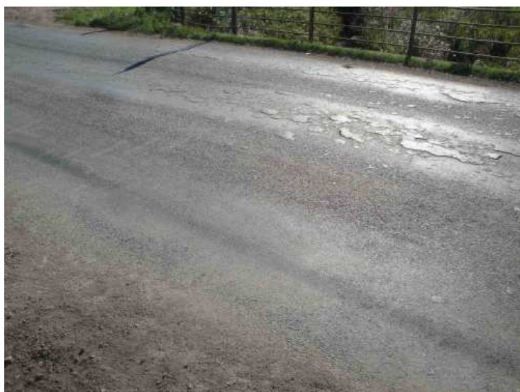
Vozovka v místě konce NK u opěry 1, zvlněný povrch, vyjeté koleje, bláto na vozovce
