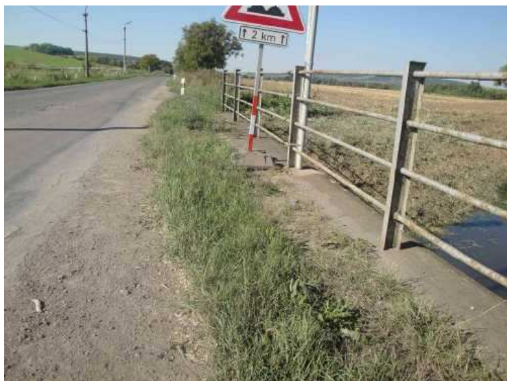
Pravá krajnice vozovky - zakořeněná tráva, krajnice nezpevněné k obrubě, převýšená vozovka
