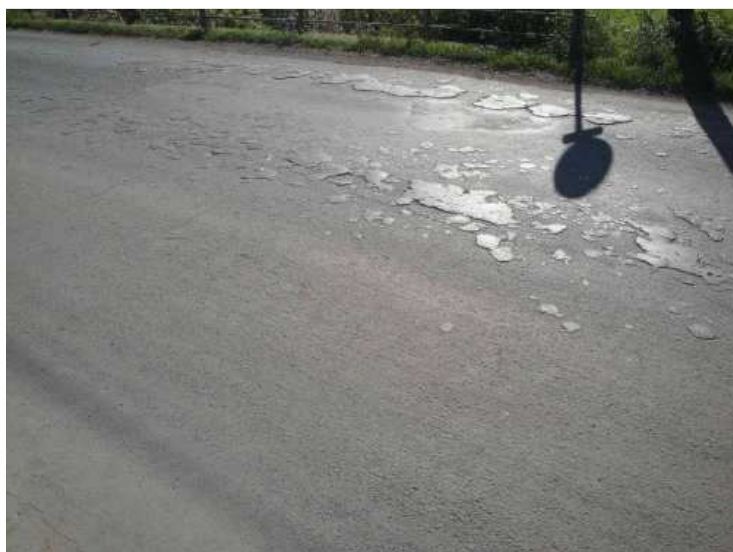
Vozovka v místě konce NK u opěry 2, zvlněný povrch, vyjeté koleje, bláto na vozovce
