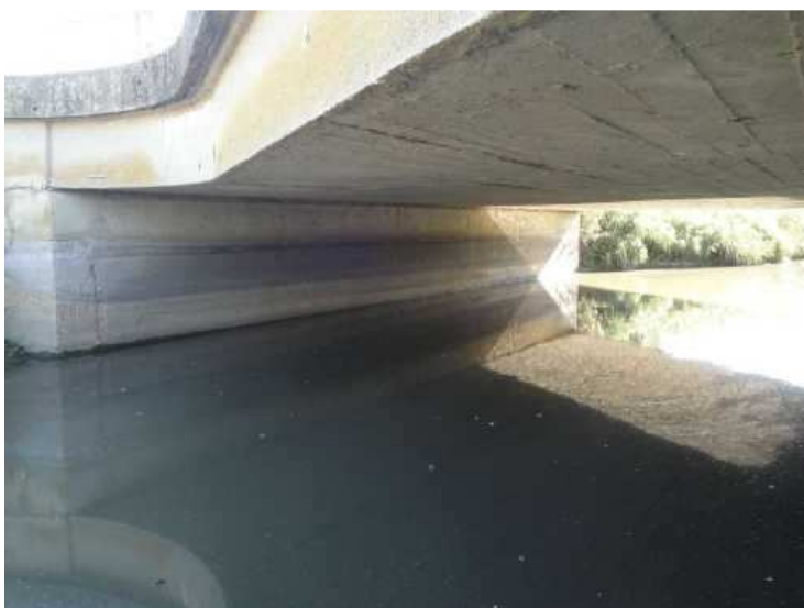
Opěra 1 - zbarvení na líci opěry kolísáním hladiny toku, průsaky pod uložením
