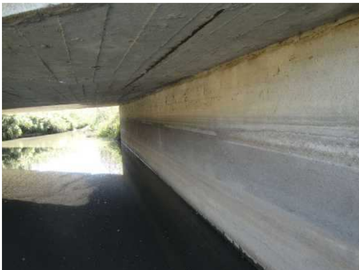
Opěra 2 - zbarvení na líci opěry kolísáním hladiny toku, průsaky pod uložením
